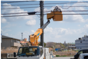
炎天下の高所作業
