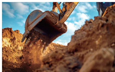
建設・工事現場など
